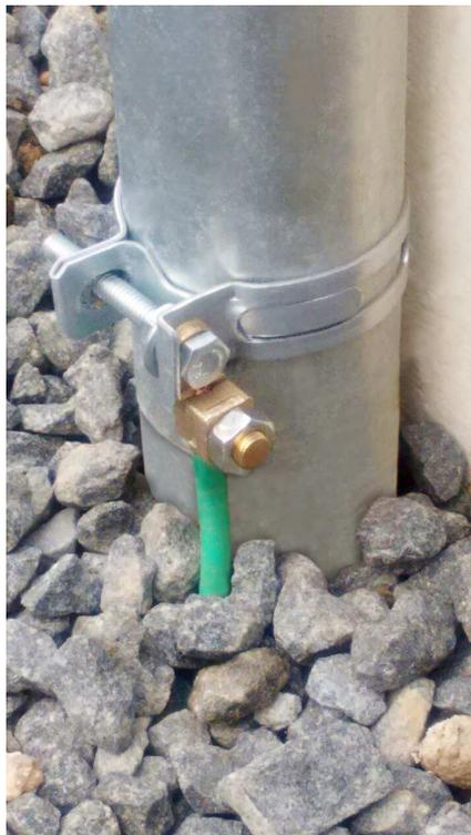
Foto ilustrativa 02 dos anexos G, H e Q – Detalhe da abraçadeira com terminal para aterramento
